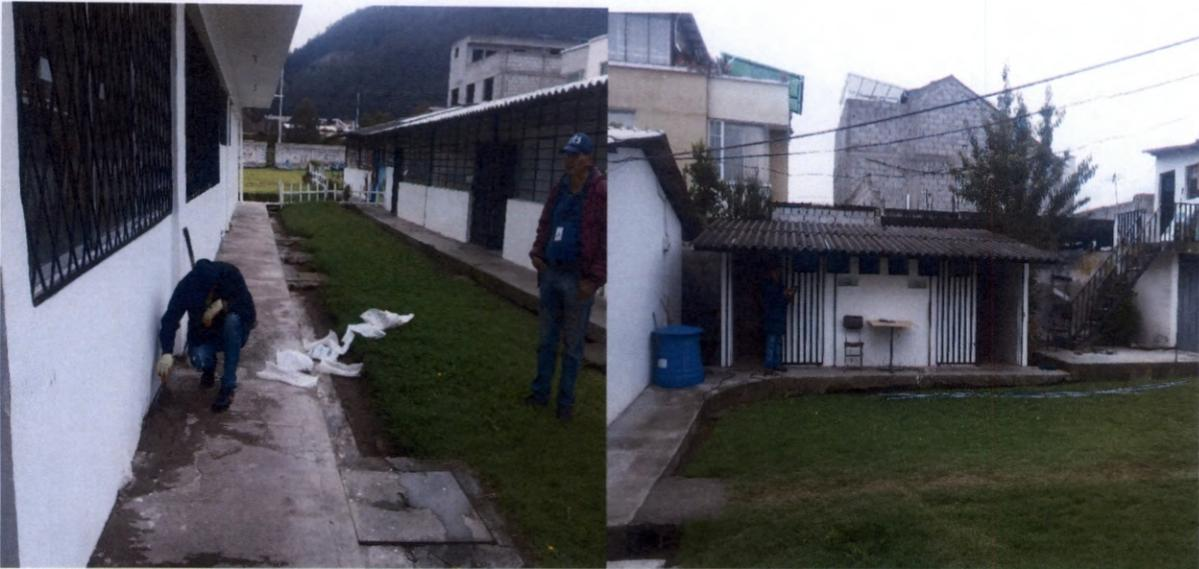
ENCEMENTADO DE VEREDA PERIMETRAL POR CAMBIO DE TUBERÍA DE AGUA POT. PARA ACOMETIDA A LOS BAÑOS DE BLOQUE PRINC.
