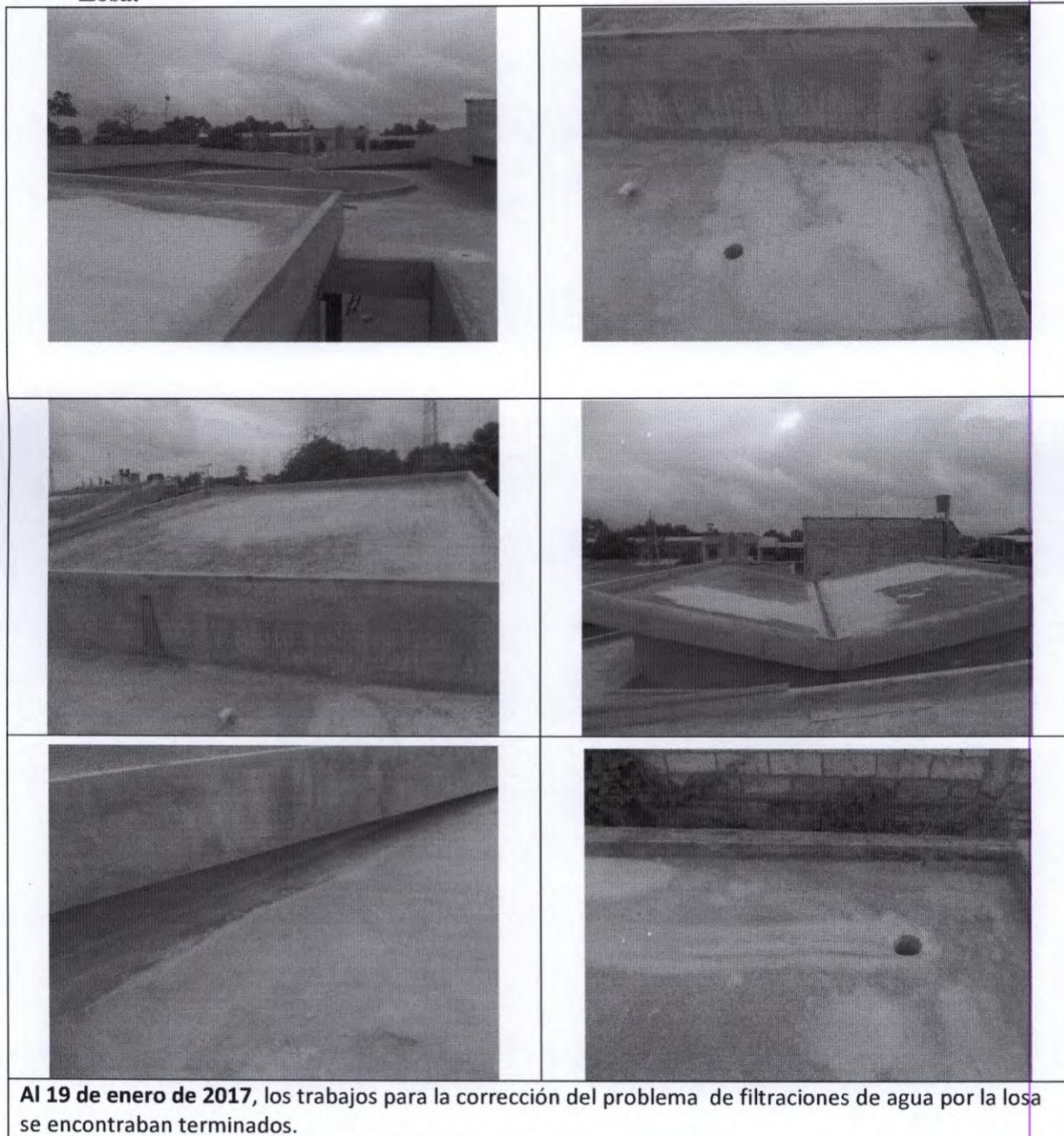
Al 19 de enero de 2017, los trabajos para la corrección del problema de filtraciones de agua por la losa se encontraban terminados.
