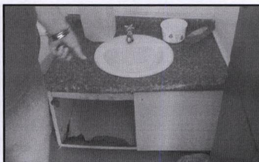
El deterioro del mobiliario de baños es producto de la falta de trabajo con los padres de familia con la finalidad de que apoyen con la mano de obra para realizar pequeños ajustes de grifería, aseguramiento de sifones de lavamanos, limpieza de cubiertas de policarbonato, revisión en general de arreglos que solo conllevan ajustes con herramienta menor y mano de obra no calificada.
