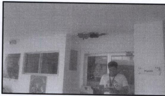
Los ventiladores requieren mantenimiento y nivelación. Incluir la construcción de una escalera para poder acceder fácilmente a la limpieza de la losa de cubierta.
