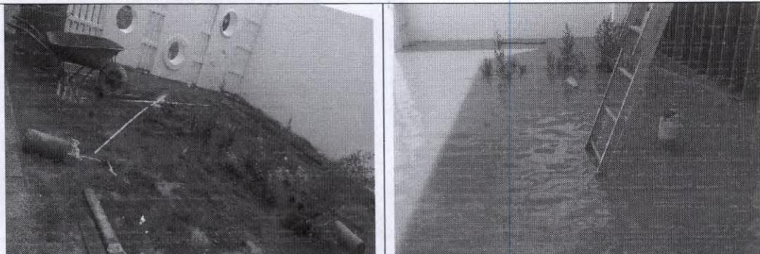
**Cajas de registro de aguas servidas, aguas lluvias y de instalaciones eléctricas inundadas**
