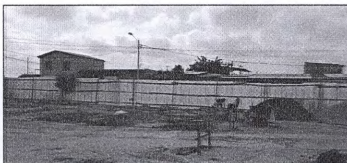
➤ CERRAMIENTO DE OBRA
