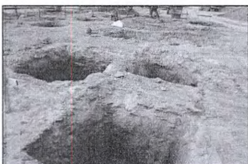
➤ EXCAVACIÓN PLINTOS
