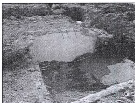
➤ ROTURA DE CISTERNA DE HORMIGÓN EXISTENTE
