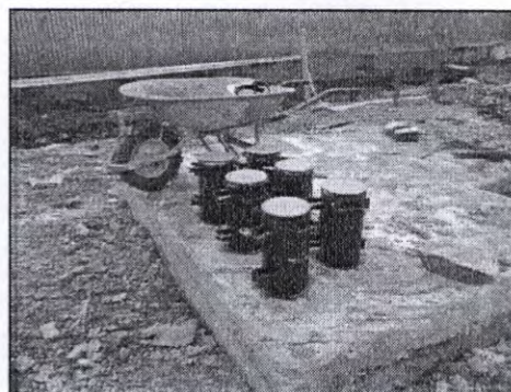
➤ TOMA DE MUESTRAS DE HORMIGÓN
