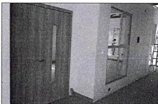
➤ PUERTAS COLOCADAS Y EN PROCESO DE ENCUADRE
